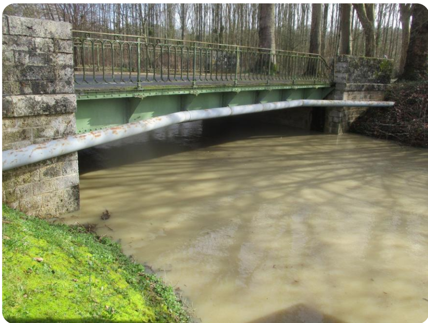
Ouvrage d'art n°1 – pont sur le bief (bras du Nahon), vers la rue de l'Abreuvoir
