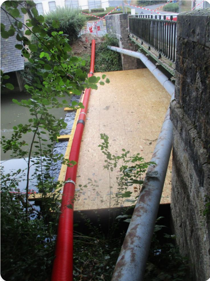
Platelage de protection et réseaux déviés au-dessus du Nahon
