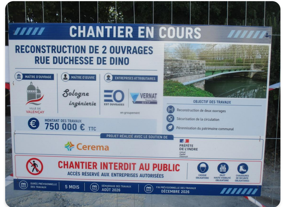
Le panneau de chantier en place rue Duchesse de Dino – chantier en cours, interdit au public
