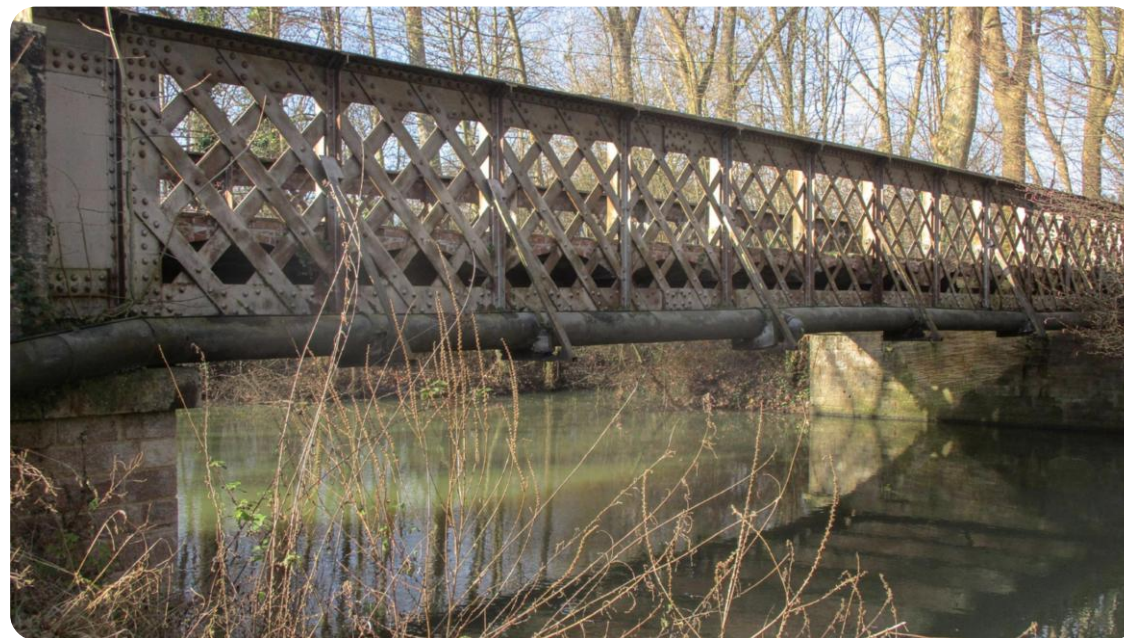
Ouvrage d'art n°2 – pont sur le Nahon, depuis la RD 960
