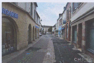
La Grande Rue avant travaux
