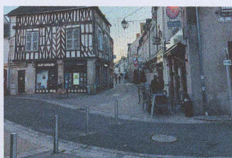
La Grande Rue avant travaux
