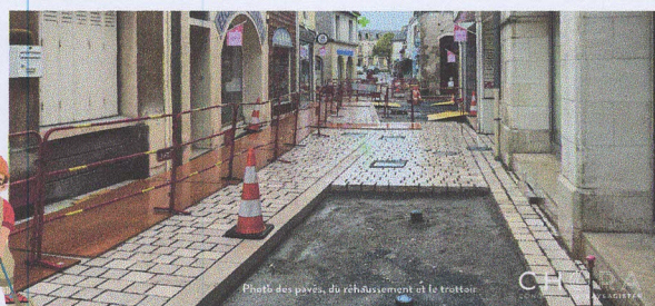
Photo des pavés, du ravalement et le trottoir
