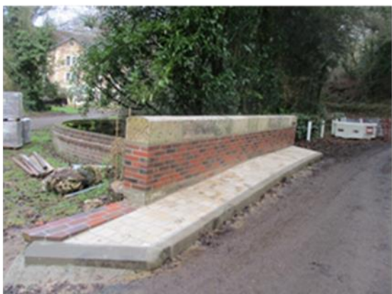
Réhabilitation de deux ouvrages d'art à Authon (41)
